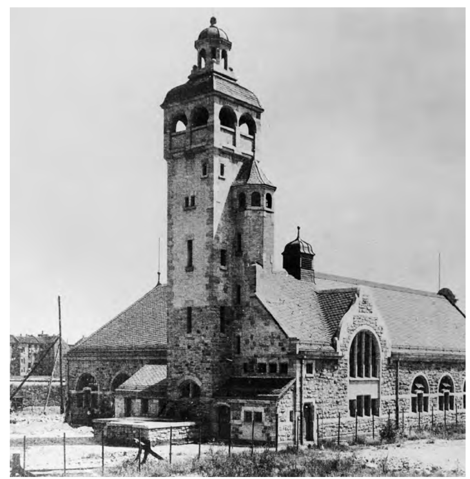
Das nach Plänen von Richard Perrey (1866–1937) entworfene Pumpwerk Ochsenpferch in der Helmholtzstraße 1–5, hier ein Foto von 1904, zitiert neuromanische Burgen- und Kirchenarchitektur, welche die technische Nutzung des Gebäudes nicht erahnen lässt. Es steht heute unter Denkmalschutz.
