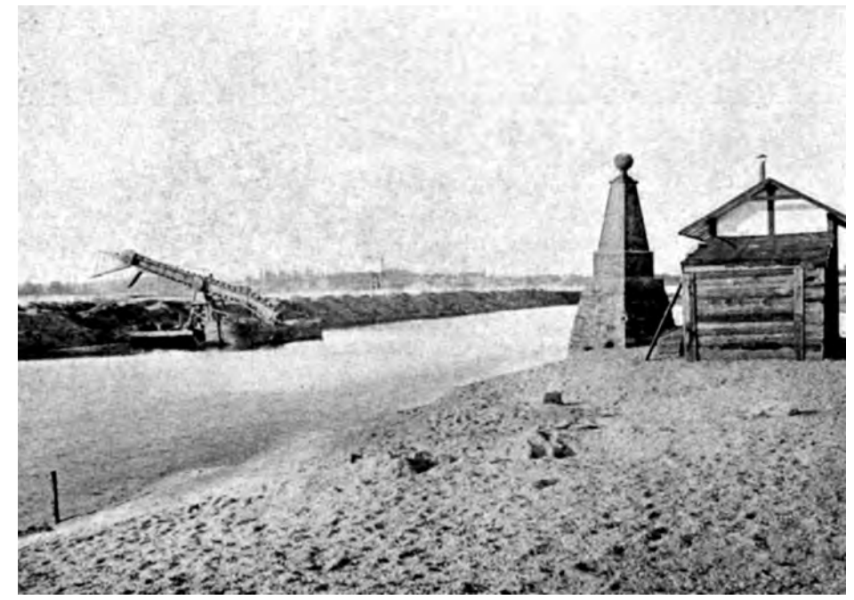
Das älteste Bauwerk auf dem Gewinn Ochsenpferch ist der sogenannte Meridian, eine 1810 errichtete Steinpyramide zur Landesvermessung. Einst dient er als Zielmarke zur Bestimmung des Mannheimer Meridians von der Sternwarte aus. Heute befindet er sich nahe seines ursprünglichen Aufstellungsortes bei der ehemaligen Einmündung des Neckars in den Rhein (Industriestr. 9). Foto um 1900.
