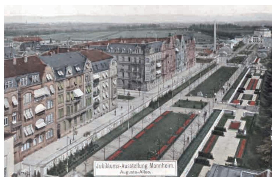
Beim Stadtjubiläum 1907 ist die Augustaanlage noch weitgehend ohne Bebauung und dient als Ausstellungsgelände. Auf dem Platz des heutigen Hotels (rechts) sind damals Mustergärten zu bestaunen. Ein riesiger Vergnügungspark schließt stadtauswärts die Augustaanlage ab. Nicht weniger als 4,6 Millionen Besucher strömen zum Jubelfest.
