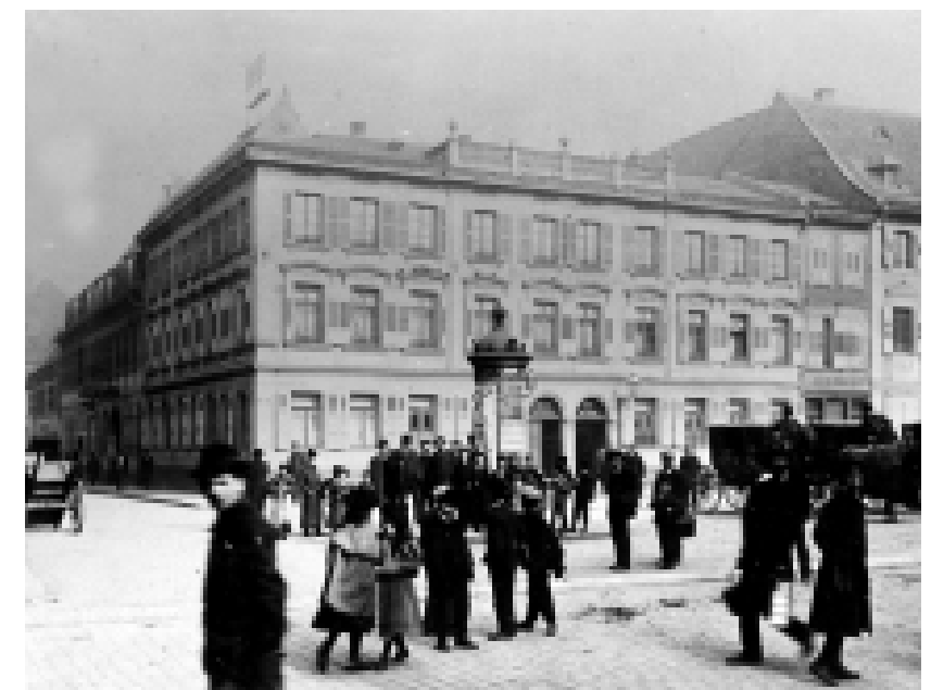
Das alt eingeführte Hotel „Portugal“ muss 1899 dem Neubau der Börse weichen.
