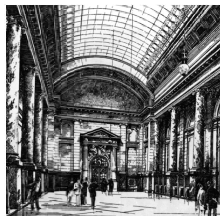
Börsensaal, Zeichnung von 1902. Die Börse wird am 5. September 1922 Ziel des ersten Anschlags von Nationalsozialisten in Mannheim: Durch eine in den Börsensaal geworfene Handgranate entsteht glücklicherweise nur Sachschaden.
